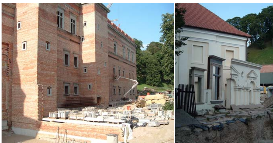
2-3. Vilnius, Il cantiere per la ricostruzione del Castello di Sigismund Augustus. Particolare dei modelli di stipiti, cornici e mensole decorative realizzati in serie.
