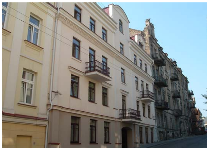
13. Recupero di una cortina edilizia a destinazione residenziale nel centro storico di Vilnius.
